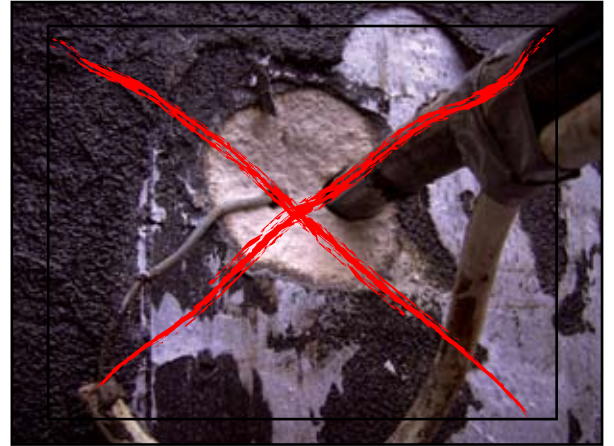
Nicht fachgerechte Einbindung der Gebäudeabdichtung
